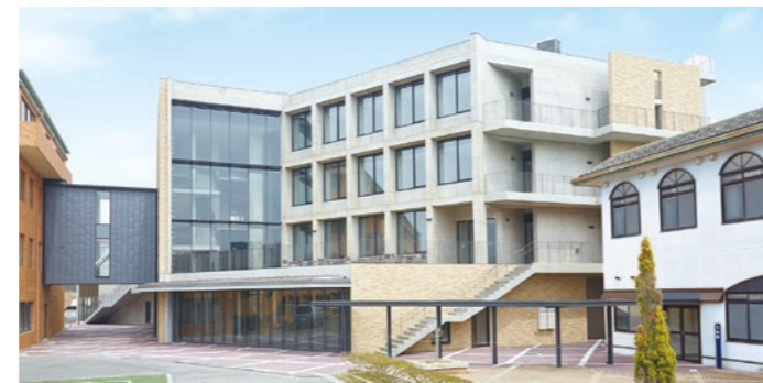
5号館(看護学実習棟) 4つの実習室を配備するとともにナーシングスキルを実践的に身につけるための施設
