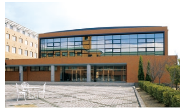
体育館 クラブ活動や授業で利用される 明るく開放的な体育館
