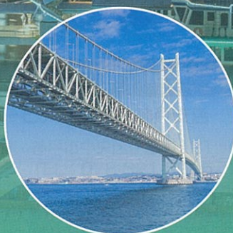
明石海峡大橋
